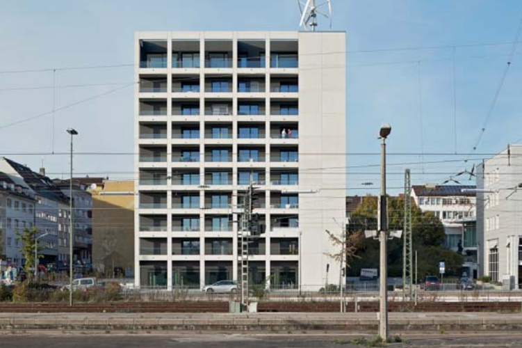
Generalsanierung Wohnhochhaus als Nullenergiehaus, Pforzheim, 2014 Foto: Dietmar Strauß
