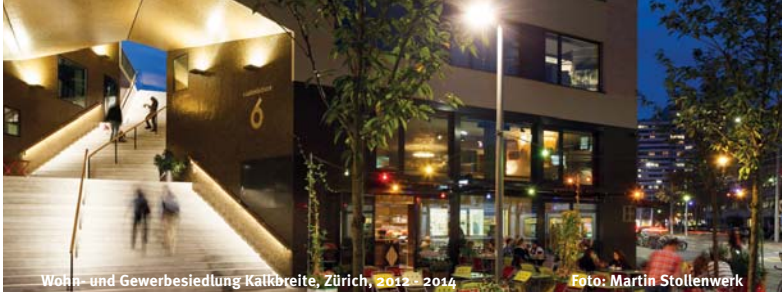
Wohn- und Gewerbesiedlung Kalkbreite, Zürich, 2012 - 2014 Foto: Martin Stollenwerk
