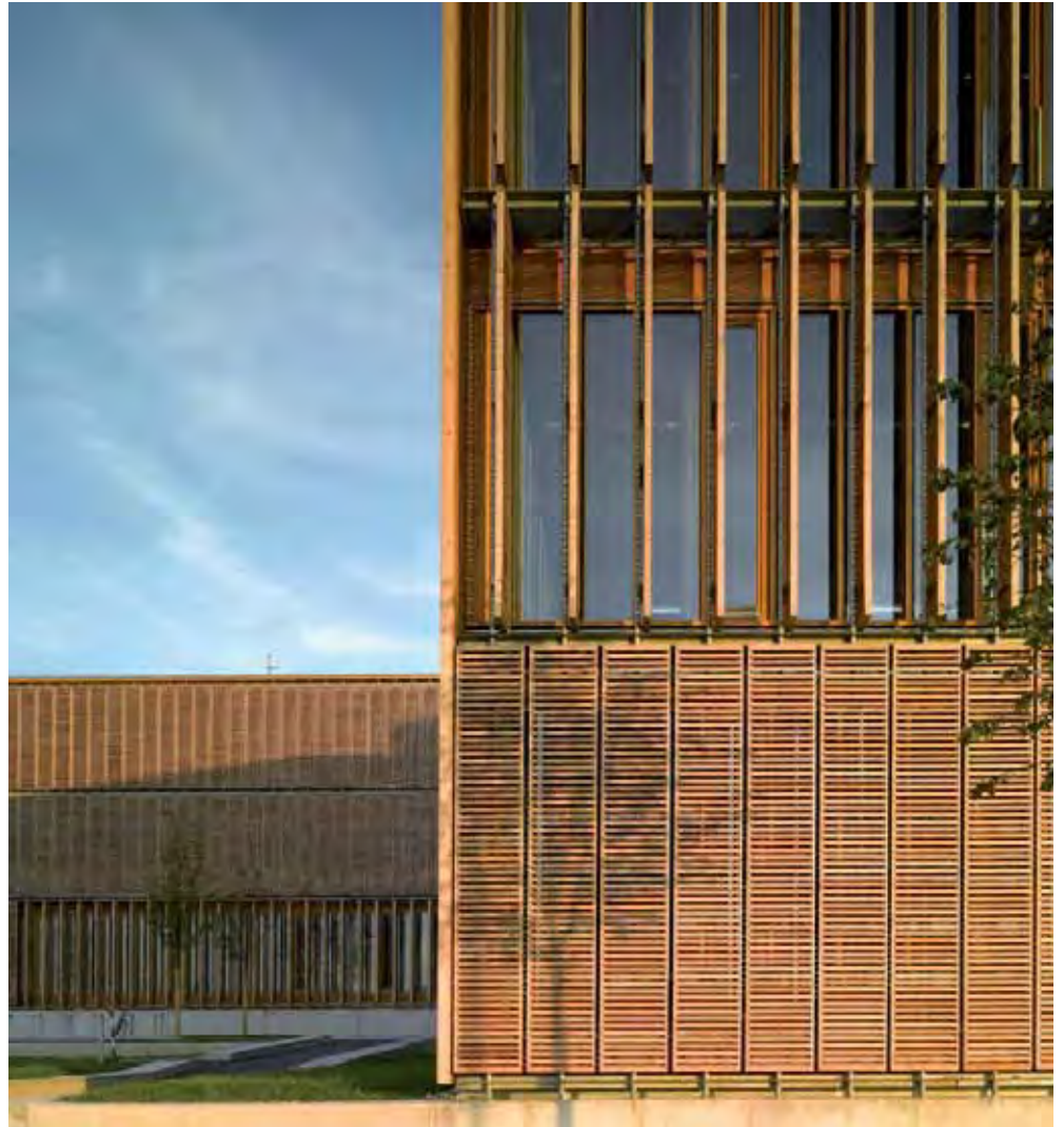
Erweiterung der Fachhochschule Aalen MGF Architekten 2007
