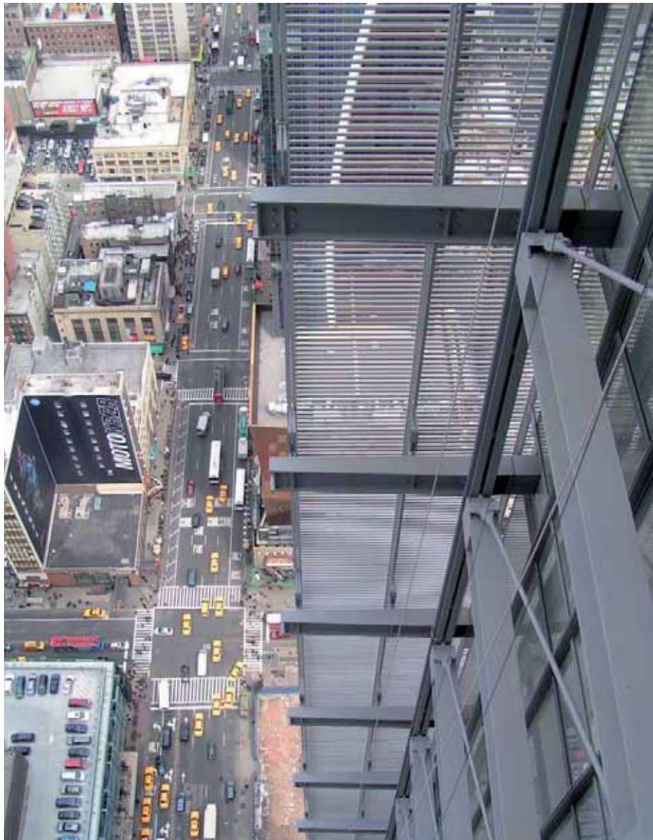
Mitentwicklung der innovativen Fassaden- und Tragkonstruktion aus glasierter Keramik am New-York Times Building in NY. Die Fassade trägt zum Corporate Identity bei und schützt den Gebäudeinnenraum vor zu hohen solaren Einstrahlungen.
