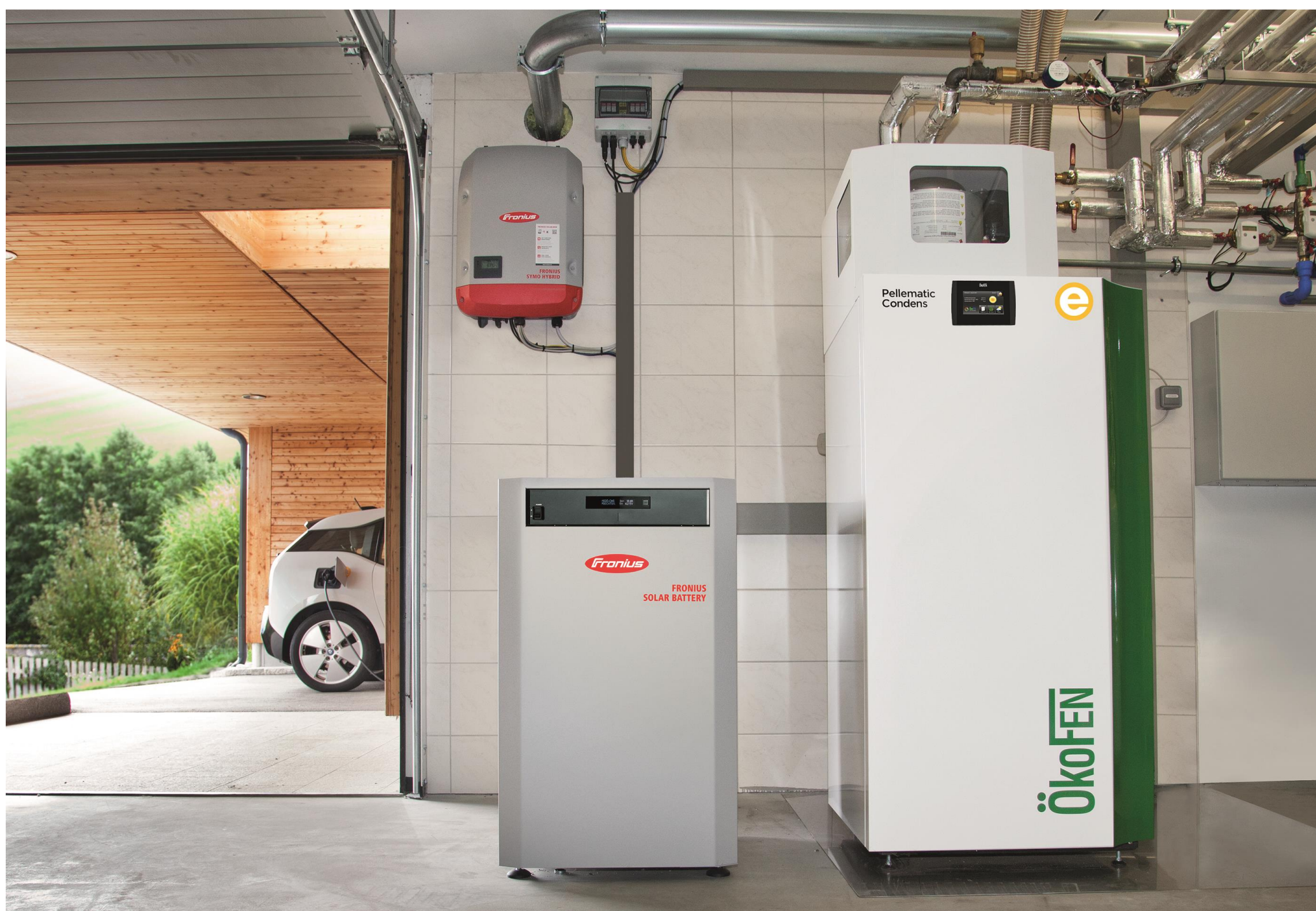
Foto: PV-Anlage, Batteriespeicher und stromerzeugende Pelletheizung ermöglichen 100% erneuerbare Energieversorgung eines Einfamilienhauses (Quelle: Ökofen)
