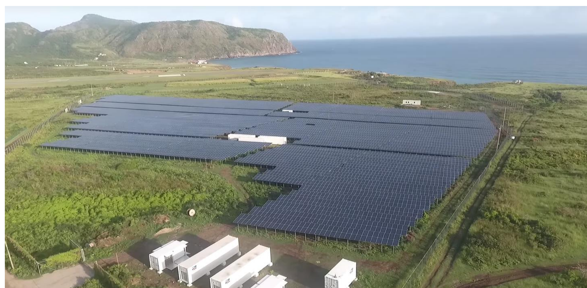
Foto: PV-Diesel Hybridsystem auf der Karibikinsel St. Eustasius (SMA AG)
