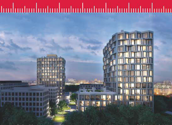
Zwei Wohnhochhäuser am Hirschgarten, München (im Bau) Bildmaterial: ASW
