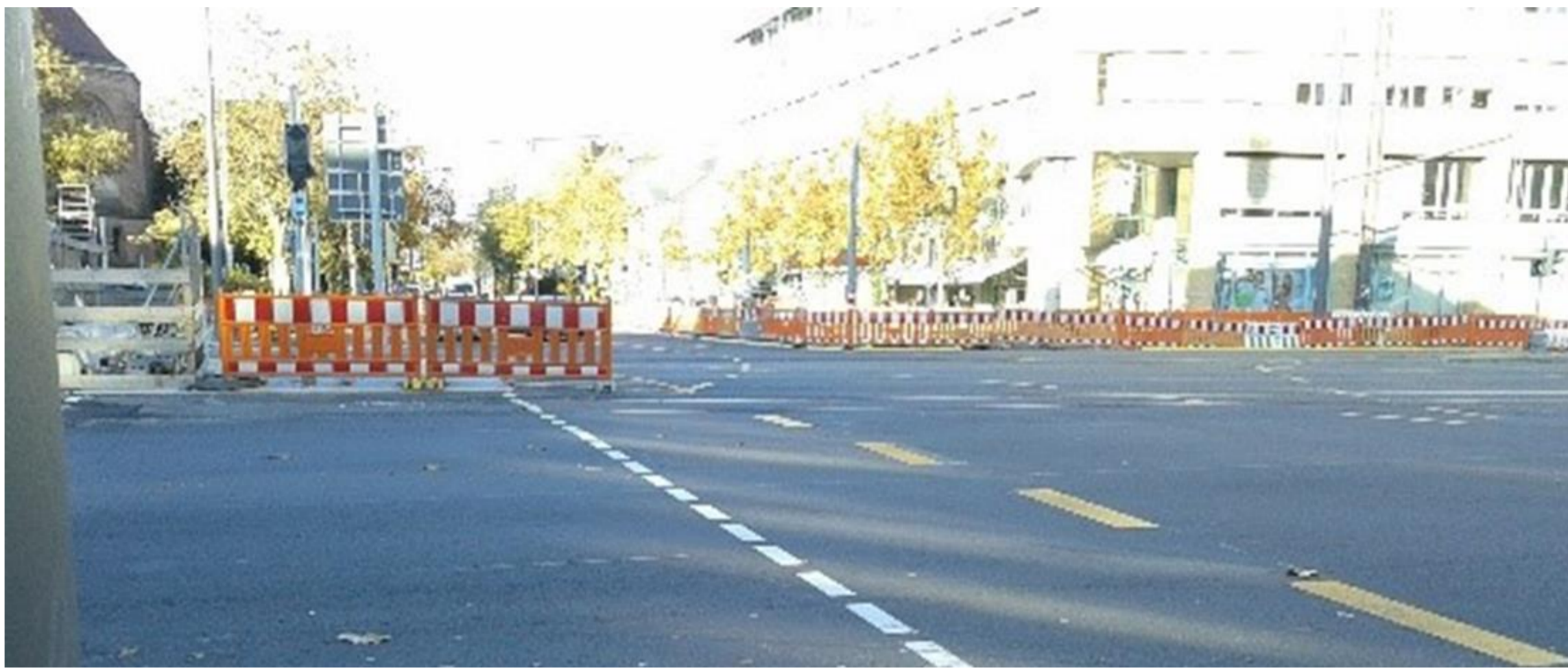
Baustellensituationen sind für Fußgänger oft unübersichtlich
